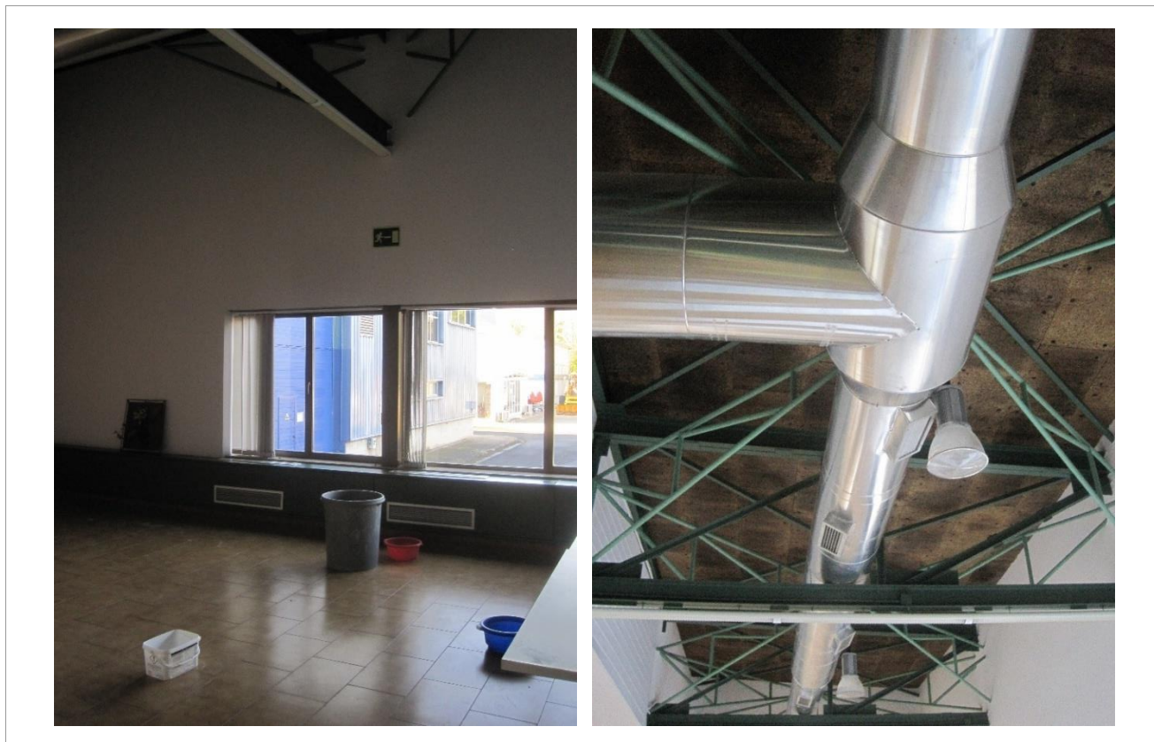
Figura 30: Fotografías del estado actual de la cubierta
