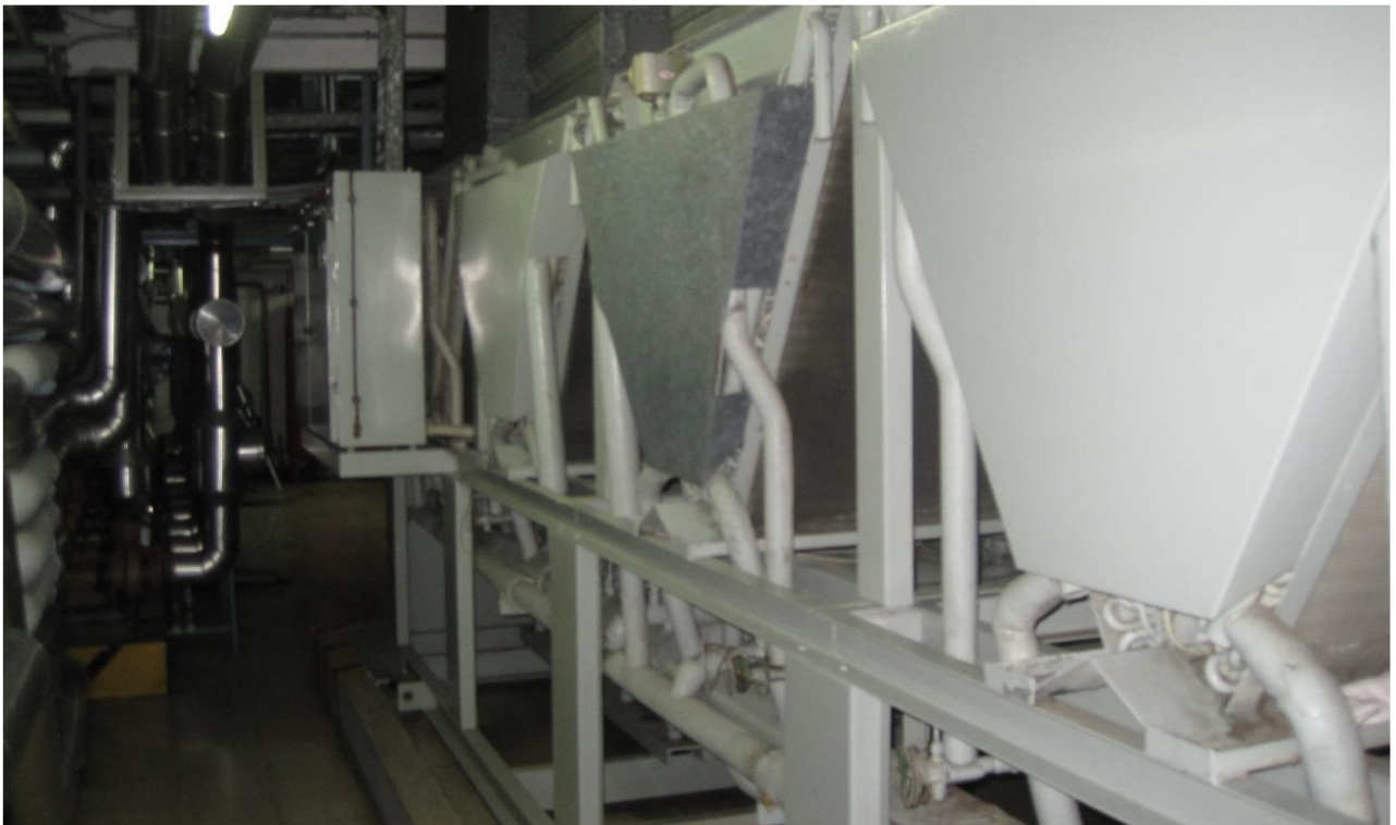
Figura 20: Fotos de las bombas de calor del sistema de climatización y ventilación
