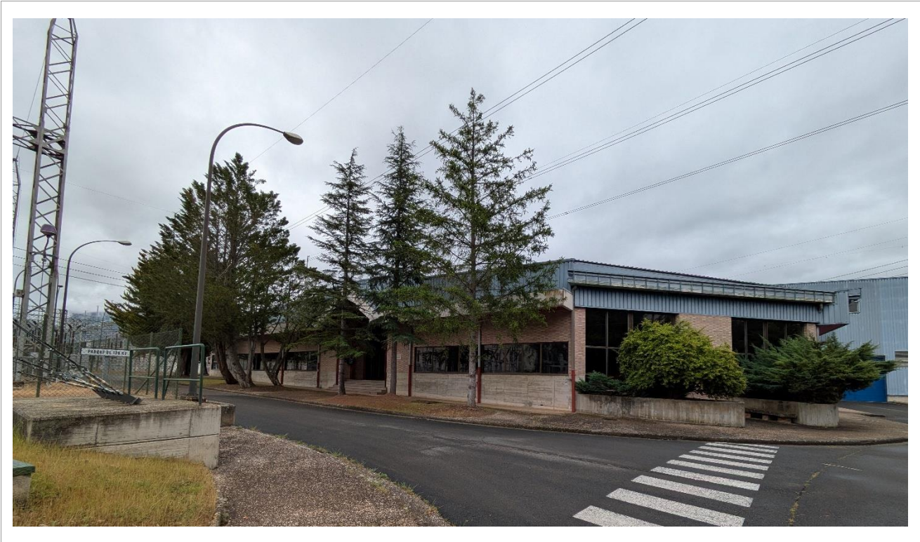
Figura 1: Edificio del comedor y cocina
