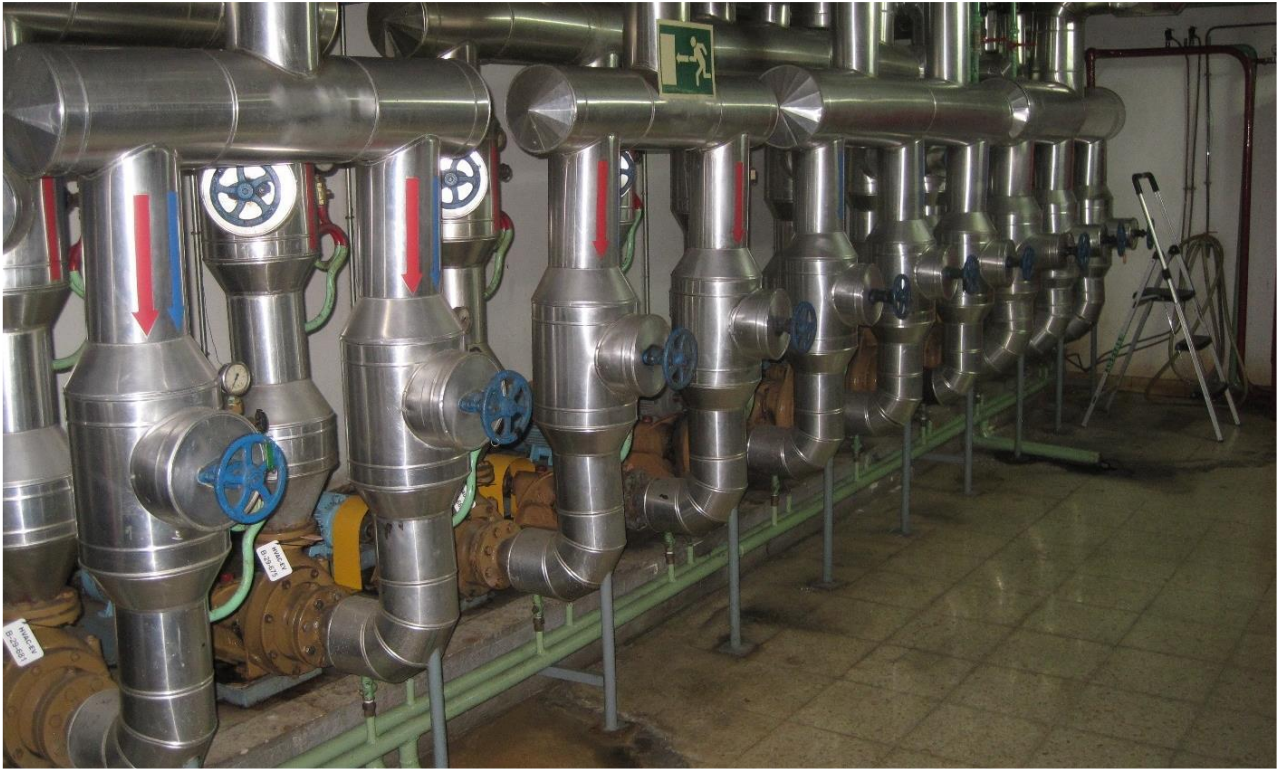
Figura 19: Fotos de las bombas del sistema de climatización y ventilación
