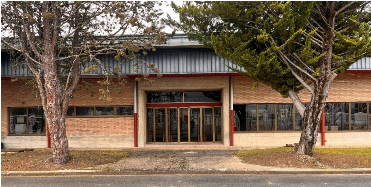
Figura 53: Fotografía del acceso este
