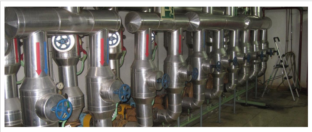
Figura 32: Fotografía del estado actual de las bombas de HVAC
