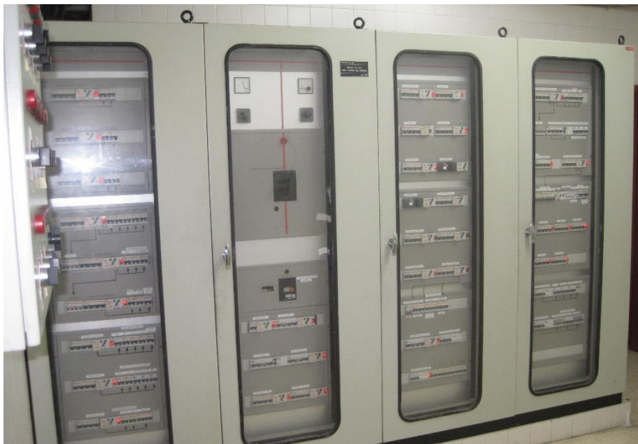
Figura 25: Fotos del cuadro eléctrico de comedor y cocina (PNLE-E2-103)
