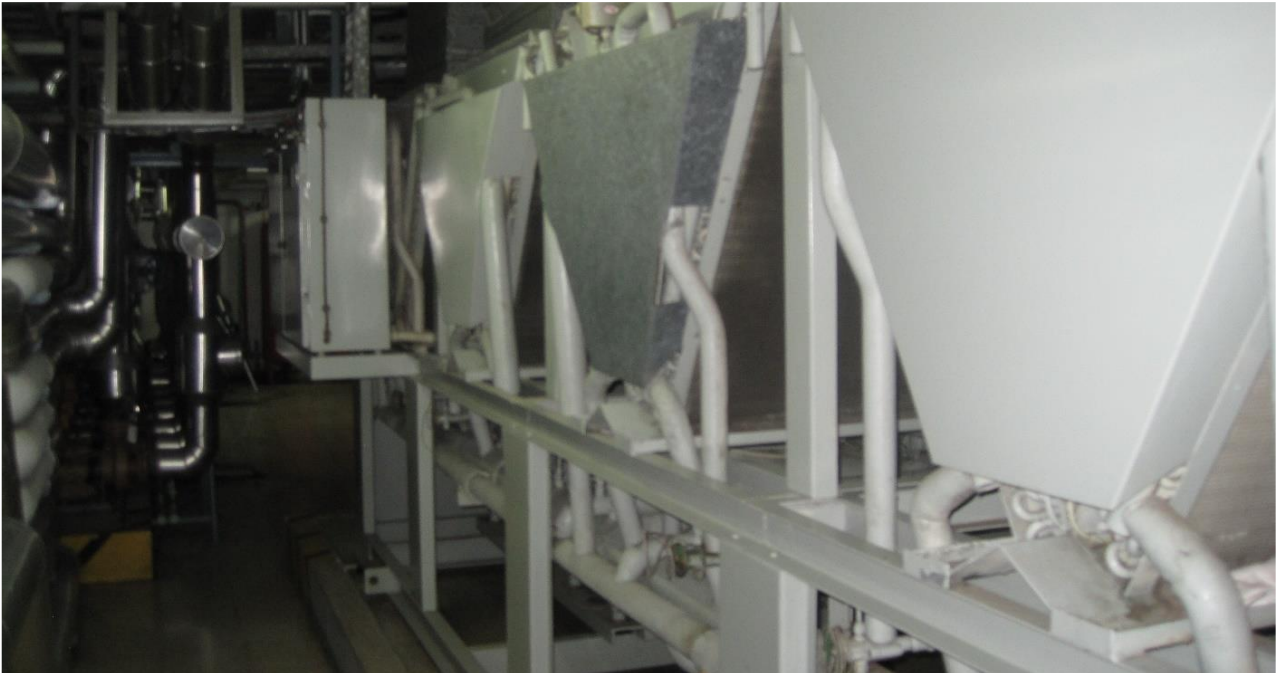
Figura 33: Fotografía del estado actual de las bombas de calor
