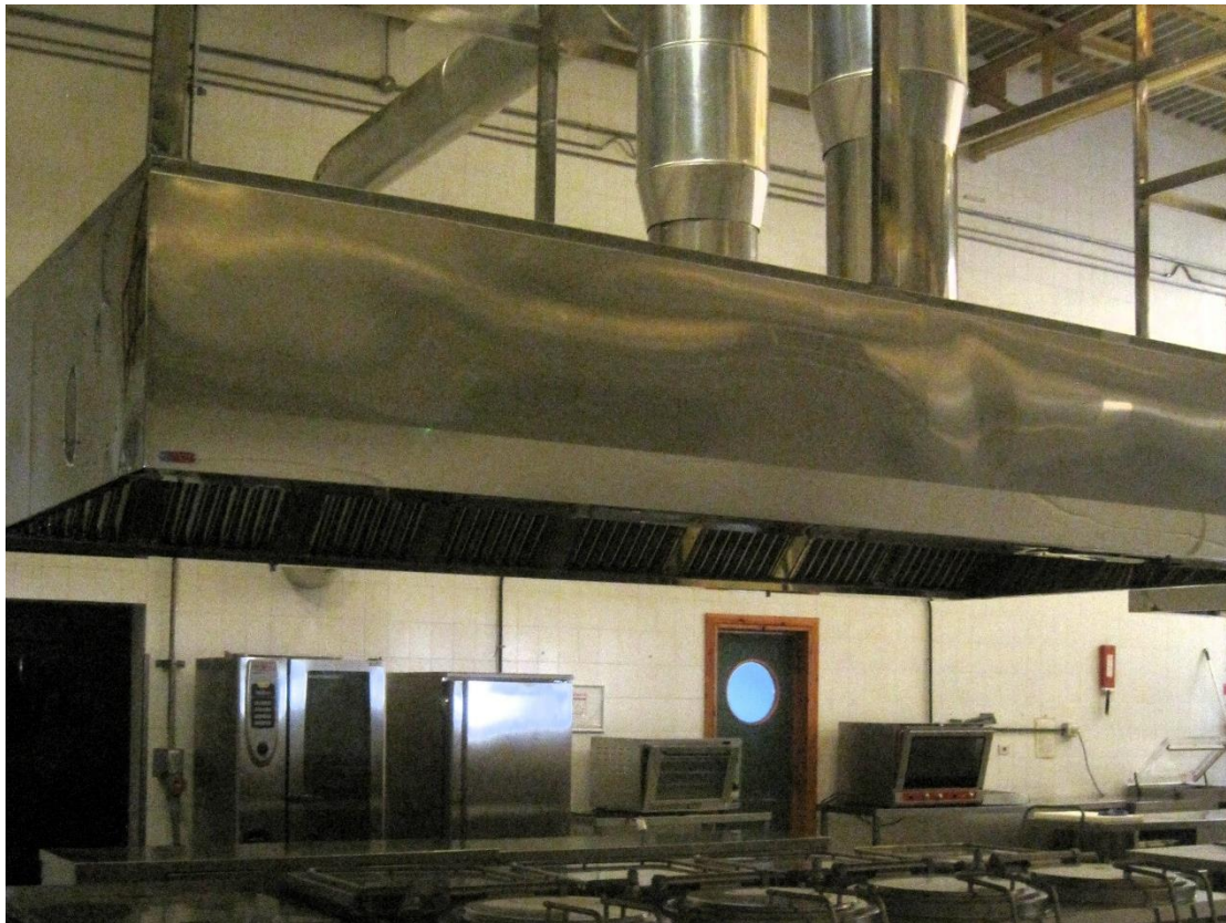
Figura 24: Foto de los equipos de extracción de la cocina
