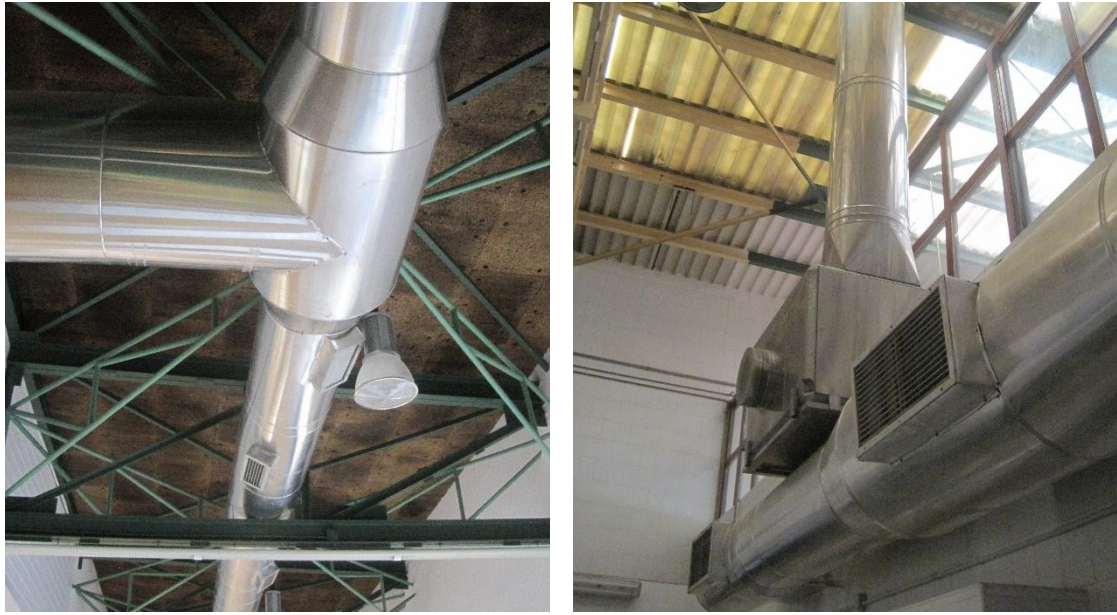
Figura 22: Fotos de componentes del sistema de climatización y ventilación
